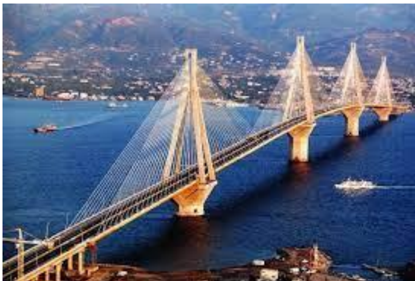
Σχήμα 2.4: Η καλωδιωτή γέφυρα Ρίου-Αντιρρίου ( www.elaktor.com )
