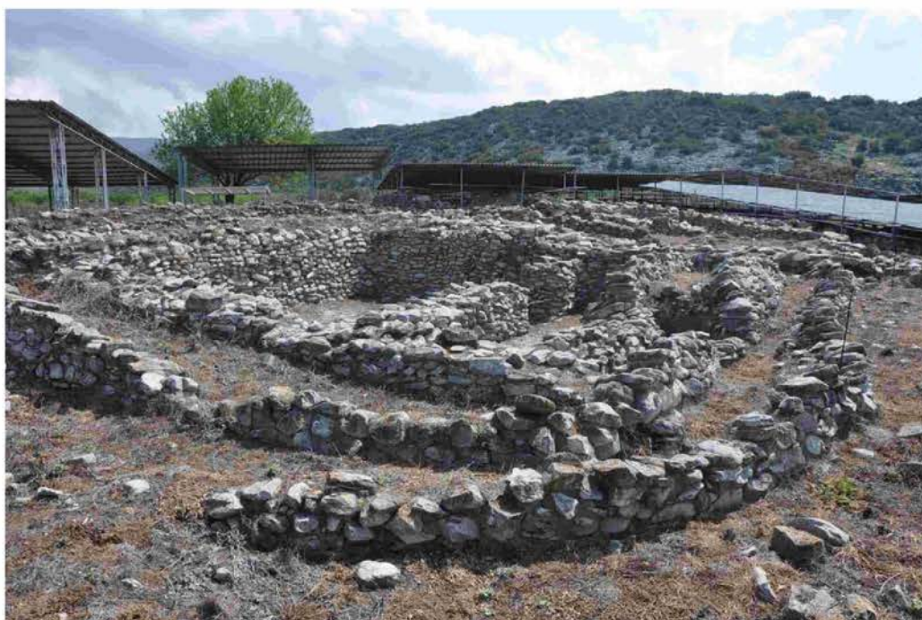
Εικ. 22: Το κεντρικό κτίριο και οι δύο αναλημματικοί περίβολοι.
