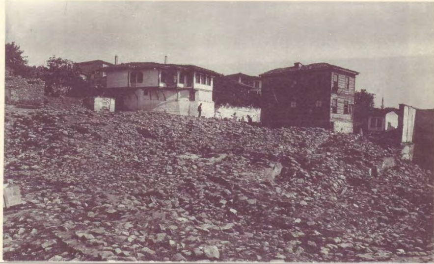
εικ. 6 : κατά τη διάρκεια κατασκευής της πλατείας
