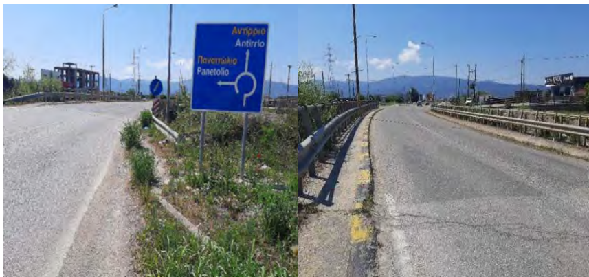
Εικόνα 7.28 Κυκλικός Κόμβος Παναιτωλίου σε μικρή απόσταση από καμπύλη ρεύμα Αγρίνιο-Χαλίκι Χ.Θ. 63+960 (Πηγή: Προσωπικό αρχείο)
