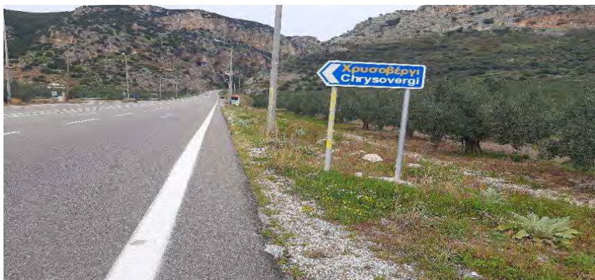
Εικόνα 7.20 Έρεισμα με κατακόρυφη πτώση πάνω από 10εκ. Χ.Θ. 49+470, ρεύμα προς Γέφυρα Ερμίτσα (Πηγή: Προσωπικό αρχείο)
