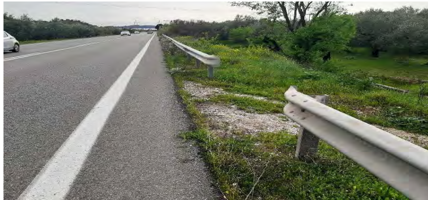
Εικόνα 7.54 Διακοπή στηθαίου για την είσοδο-έξοδο από ιδιοκτησία Χ.Θ.: 48+865 (Πηγή: Προσωπικό αρχείο)
