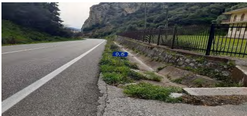
Εικόνα 7.19 Έρεισμα και ανοιχτή τάφρος αποχέτευσης όμβριων υδάτων Χ.Θ. 50+500 ρεύμα προς Χαλίκι (Πηγή: Προσωπικό αρχείο)
