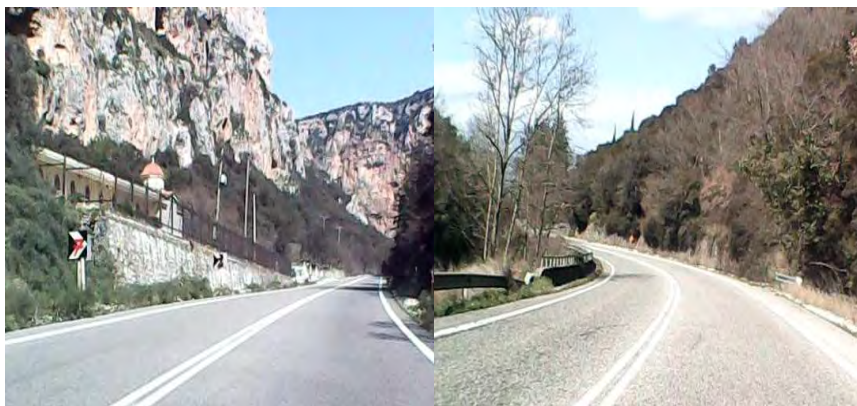
Εικόνες 7.10 Απαγόρευση προσπέρασης λόγω αυξημένης κατά μήκος κλίσης Χ.Θ.. 50+400 και απαγόρευση προσπέρασης λόγω μικρής ακτίνας καμπυλότητας Χ.Θ. 53+100 (Κατεύθυνση τους Γέφυρα Ερμίτσας, ) (Πηγή: Προσωπικό αρχείο)
