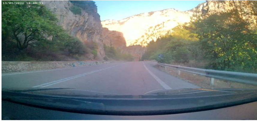
Εικόνα 7.39 Ενδεικτική θέση απόκρυψης πινακίδας λόγω βλάστησης (Χ.Θ. 51+080 , Ρεύμα Μεσολόγγι-Αγρίνιο)
