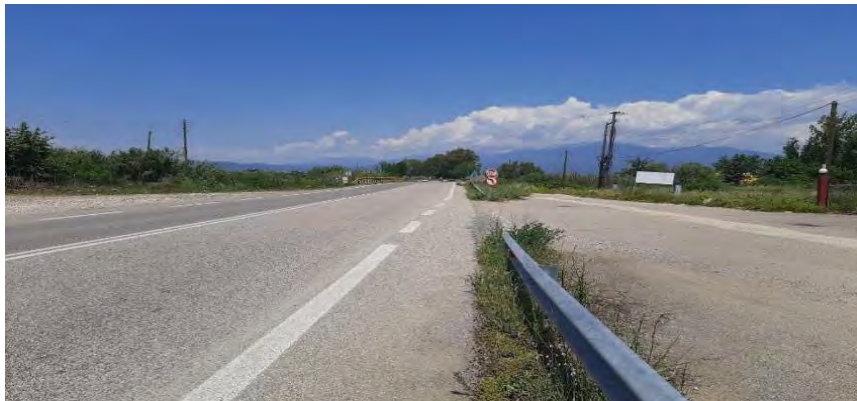
Εικόνα 7.45 Ενδεικτικά: ύπαρξη διπλής συνεχόμενης γραμμής για διαχωρισμό λωρίδας αντίθετης κατεύθυνσης λόγω είσοδο στην Ε.Ο από εγκάρσιο δρόμο και ύπαρξη καμπύλης Χ.Θ. 59+700, ρεύμα προς Αγρίνιο (πηγή: προσωπικό αρχείο)
