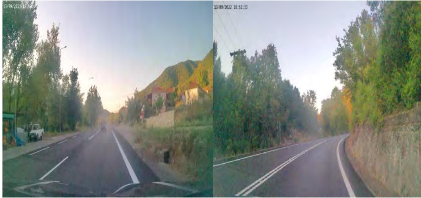
Εικόνα 7.22 Αποχέτευση με κλειστό αγωγό όμβριων, Χ.Θ . 53+500 & Εικόνα 8 ύπαρξη ανοιχτής τριγωνικής τάφρου Χ.Θ. 55+300 , ρεύμα Χαλίκι-Ερμίτσα (Πηγή: Προσωπικό αρχείο)
