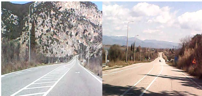
Εικόνα 7.1 Επαρκές μήκος ορατότητας στον πρώτο Κόμβος Χρυσοβεργίου Χ.Θ.: 49+580 & στον δεύτερο Κόμβος Λυσιμαχίας Χ.Θ. 56+690 Ρεύμα Χαλίκι-Γέφυρα Ερμίτσας (Πηγή: Προσωπικό αρχείο)
