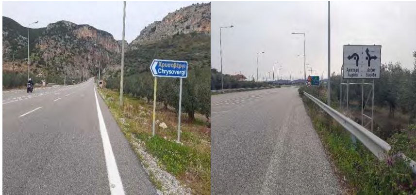
Εικόνα 7.16 Στύλοι οδοφωτισμού στον Κόμβο Χρυσοβέργιου Χ.Θ.49+470 (Κατεύθυνση προς Γέφυρα Ερμίτσας, ) και Κόμβο Χαλικίου Χ.Θ. 48+570 (Κατεύθυνση προς Κόμβο Χαλικίου ) (Πηγή: βιντεοσκόπηση)
