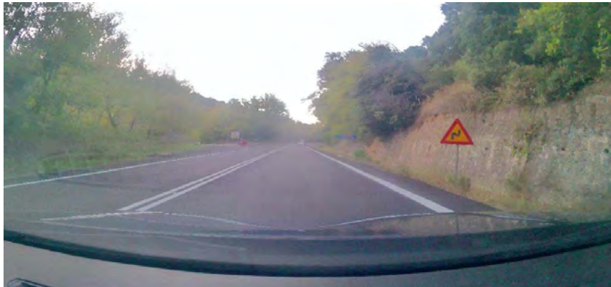
Εικόνα 7.46 Ενδεικτικά: Υπάρξη πινακίδας K026 στη Χ.Θ. 55+015, ρεύμα προς Αγρίνιο (πηγή: βιντεοσκόπηση)
