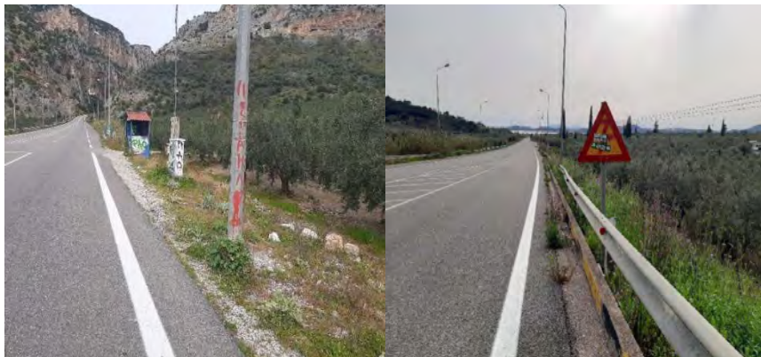
Εικόνα 7.57 Στάση δημόσιας συγκοινωνίας σε μικρή απόσταση από οριογραμμή οδοστρώματος στον κόμβο Χρυσοβεργίου (Χ.Θ. 49+580) και σήμανση για διάβαση πεζών στη Χ.Θ. 49+750 Ρεύμα προς Χαλίκι με δισδιάκριτη πληροφορία
