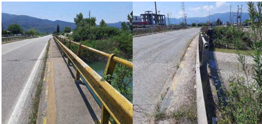
Εικόνα 7.18 Γέφυρα Αλάμπεη Χ.Θ. 59+580 Κατεύθυνση προς Γέφυρα Ερμίτσα & Εικόνα 5 Γέφυρα Ερμίτσας Χ.Θ. 63+950 Ρεύμα προς Χαλίκι (Πηγή:Προσωπικό αρχείο)
