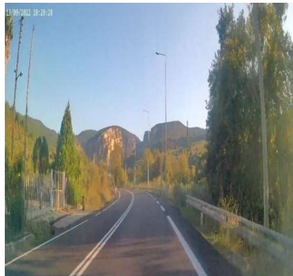
Εικόνα 7.4 Επικίνδυνη έξοδος από εγκάρσιο δρόμο προς Εθνική Οδό -Ελλειψης ορατότητας λόγω βλάστησης (Ενδεικτικά Χ.Θ. 54+170 Κατεύθυνση προς Χαλίκι (Πηγή: βιντεοσκοπήση)
