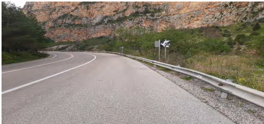
Εικόνα 7.21 Αριστερόστροφη καμπύλη με αρνητική επίκλιση, Χ.Θ. 51+500, ρεύμα προς Γέφυρα Ερμίτσα
