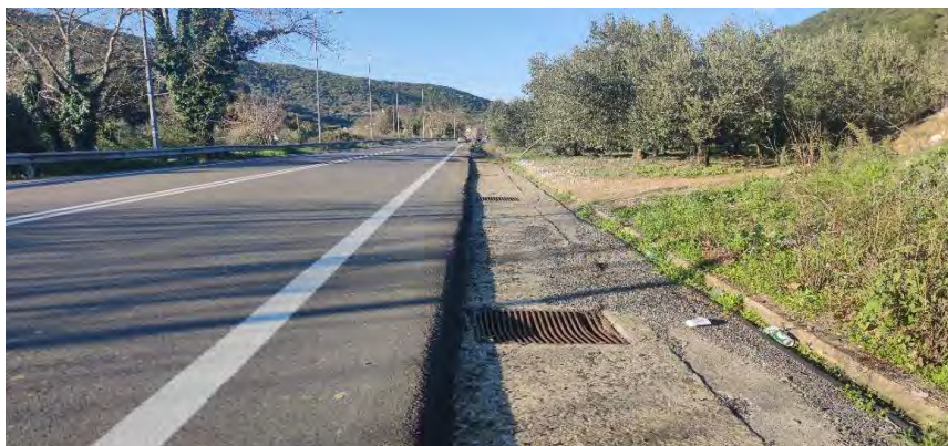
Εικόνα 7.60 Σχάρα υδροσυλλογής ομβριων υδάτων στην Χ.Θ. 53+950 Ρεύμα Χαλίκι-Γέφυρα Ερμίτσα (Πηγή: Προσωπικό αρχείο)
