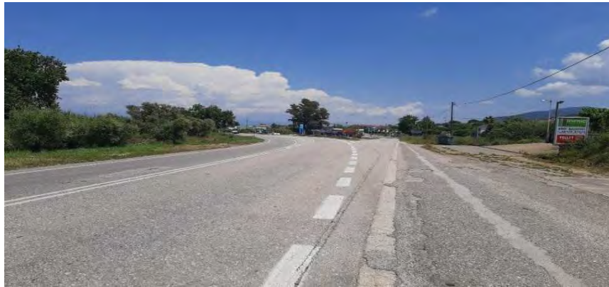
Εικόνες 7.13 Αύξηση πλάτους οδού λόγω συμβολής με παράπλευρο δρόμο και πρόσβαση σε ιδιοκτησίες Χ.Θ..63+050 (Κατεύθυνση προς Γέφυρα Ερμίτσας, ) (Πηγή: προσωπικό αρχείο)
