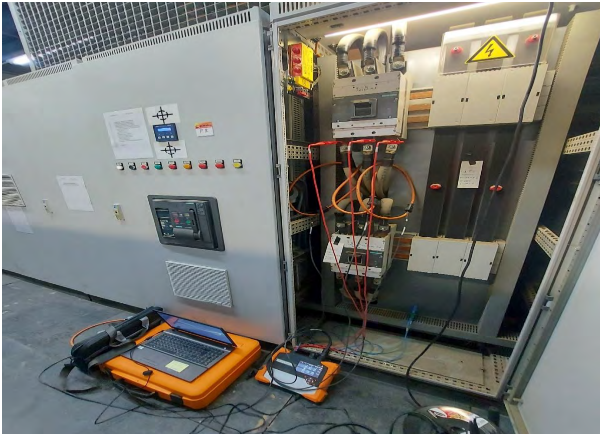
Εικόνα 99: Συνδεσμολογία μετρητικού οργάνου στις 3 φάσεις του drive.
