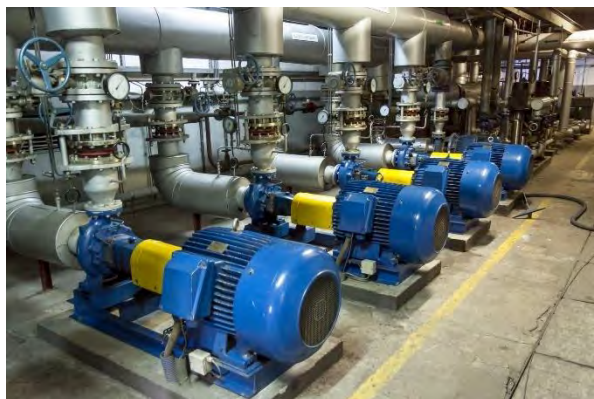
Εικόνα 7: Οι επαγωγικοί ηλεκτροκινητήρες σε βιομηχανία. Το πιο συνηθισμένο είδος εξοπλισμού. (ΠΗΓΗ: EcoAmbassador Academy)
