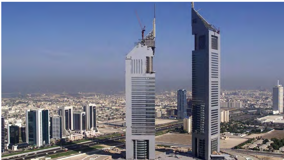
Εικόνα 25 Μια εναέρια άποψη των πύργων της Emirates υπό κατασκευή τον Νοέμβριο του 1999.
