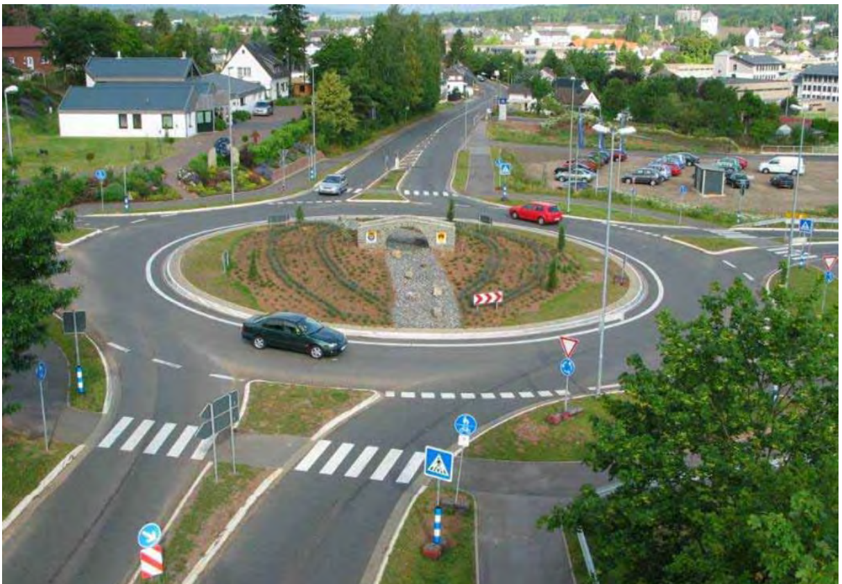
Εικόνα 6. Σύγχρονος Κυκλικός Κόμβος Μίας Λωρίδας (Brilon, 2011)
