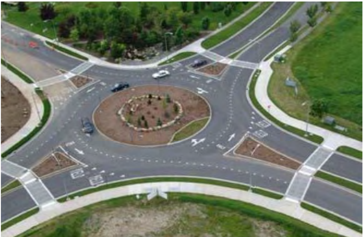
Εικόνα 15. Κυκλικός Κόμβος Δύο Λωρίδων (Brilon, 2011).
