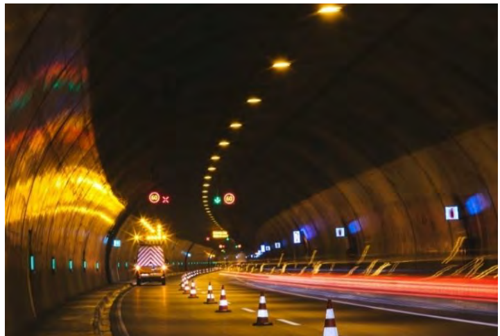
Εικόνα 12: Εσωτερικό τμήμα της σήραγγας στην διάρκεια εργασιών
