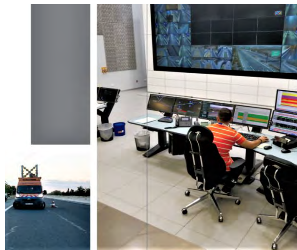
Εικόνα 13: Κέντρο ελέγχου ασφαλείας σιράγγων Πηγή: Aegeanmotorway
