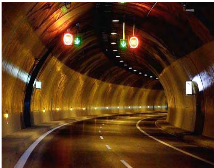
Εικόνα 3: Εσωτερικό σήραγγας Τ2 Πηγή: (Aegeanmotorway, 2021)
