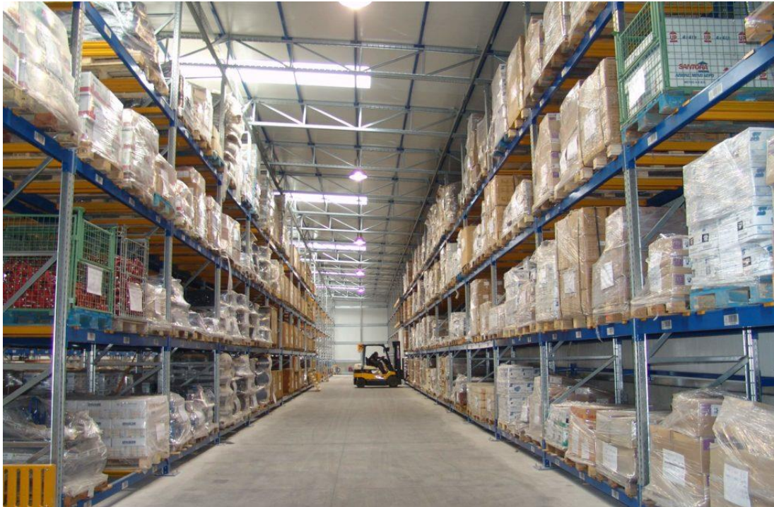
Εικόνα 2.1: Τυπική εγκατάσταση ραφιών παλετών αποθήκης
