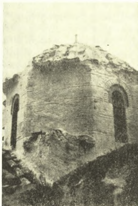
Εἰκ. 9. Τὰ μονόλοβα παράθυρα τοῦ τρούλλου μετὰ διπλῶν πλινθίνων τόξων.
