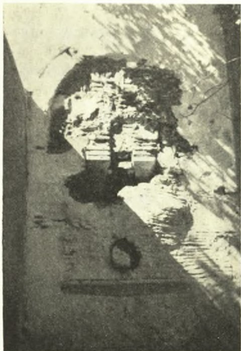
Εἰκ. 3. Τὸ τρίλοβον παράθυρον τῆς ἀψίδος τοῦ ἱεροῦ μετὰ τὴν μερικὴν ἀπομάκρυνσιν τῶν ἐπιχρίσεων ἀσβέστου.
