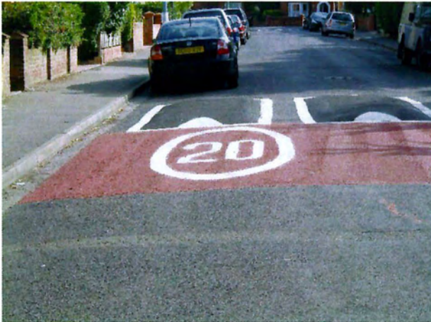
Εικόνα 9: Μαξιλάρια κατασκευασμένα από άσφαλτο
