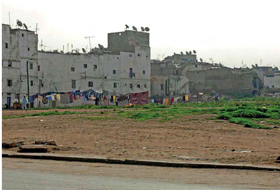
Αυτόκτιστη γειτονιά στο κέντρο της Καζαμπλάνκα, 2008. Φωτογραφία: Marion von Osten.
