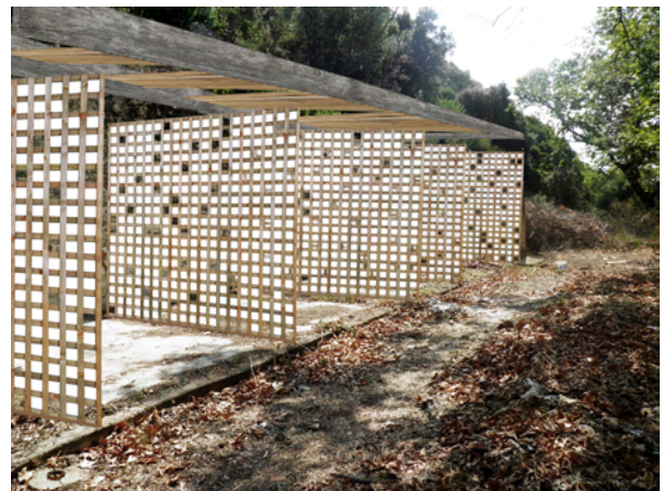
Τοιχοποιία ημισυπαίθριων λουτρών
