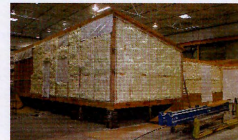
ΕΙΚ.188_ Μη τοξικός αφρός μόνωσης τοποθετείται στο εργοστάσιο (πηγή:βιβλίο "Prefab Green", των Michelle Kaufmann/ Catherine Remick, Σελ.64)
