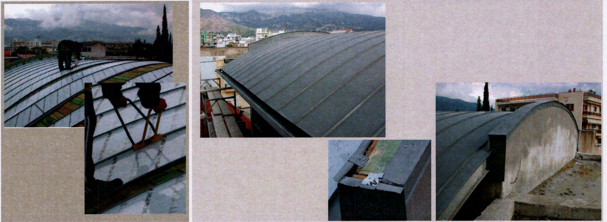
εικ. 256-263_φωτογραφίες κατασκευής μεταλλικής προσθήκης κατοικίας στην οδό Αμπελακίων, στον Βόλο, (2011), (πηγή: προσωπικό αρχείο Κ.Αδαμάκη)
