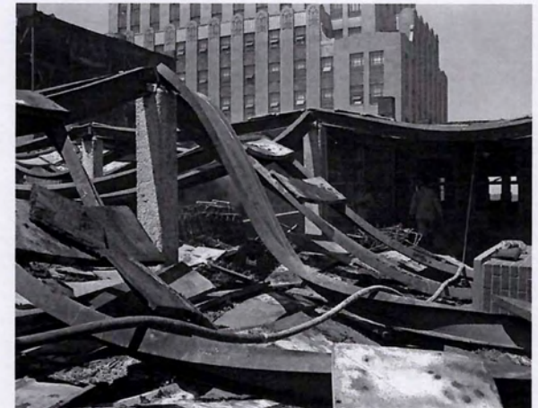
εικ.158_ Δοκοί χάλυβα μετά από πυρκαγιά, (πηγή: http://blogs.sj-r.com/behindthecurtain/index.php/2009/05/03/to-wering-inferno/ )
