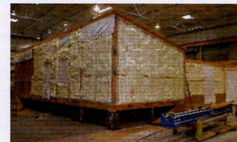
ΕΙΚ.188_ Μη τοξικός αφρός μόνωσης τοποθετείται στο εργοστάσιο (πηγή:βιβλίο "Prefab Green", των Michelle Kaufmann/ Catherine Remick, Σελ.64)
