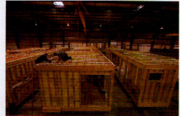
ΕΙΚ.280 Κατασκευή της κατοικίας "MSI Mksolaire" στο εργοστάσιο, (πηγή: βιβλίο Prefab Green, των Michelle Kaufmann/ Catherine Remick, Σελ. 128)
