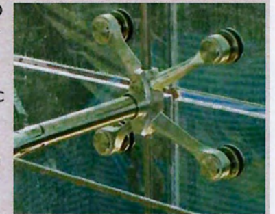
ΕΙΚ.129 Στοιχεία "spider" (πηγή: http://www.skgazing.com/benefits_of_spider_glass_system.htm )
