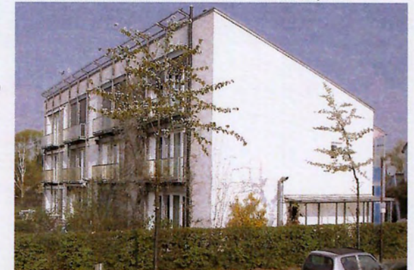
ΕΙΚ.62 Στην ανατολική πλευρά διακρίνεται το στόμιο εξαερισμού της κατοικίας ακόμη και αν τα παράθυρα μένουν κλειστά για αρκετές μέρες, και ΕΙΚ. (κάτω) "Παθητική κατοικία" στο Darmstadt Kranichstein
