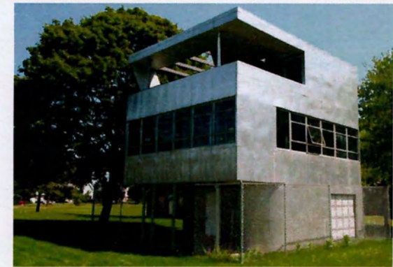
ΕΙΚ.147_ Επικάλυψη κτιρίου με αλουμίνιο, (πηγή: http://2ndterm2007.blogspot.com/ )
