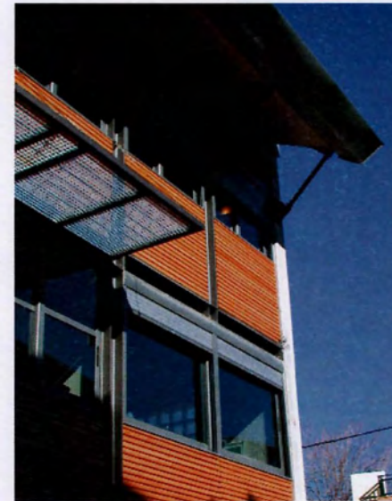
εικ.247-9 _λεπτομέρειες στέγης τιτανιούχου ψευδάργυρου μεταλλικού κτιρίου κατοικίας οδού Αμπελακίων στον Βόλο, (2011), (πηγή: προσωπικό αρχείο Κ.Αδαμάκη)
