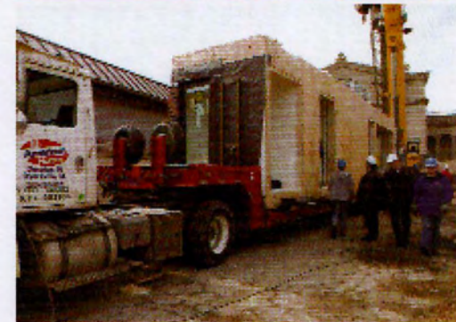
εικ.204-6_Συναρμολόγηση, τοποθέτηση μόνωσης, μεταφορά μονάδων (πηγή: βιβλίο "Prefab Green", των Michelle Kaufmann/ Catherine Remick, Σελ.66)
