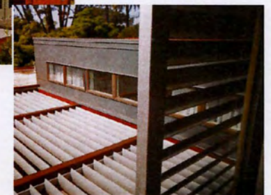
ΕΙΚ.273_Οι περσίδες λειτουργούν σαν σκηνή, επιτρέποντας τον αερισμό μέσα στα υπνοδωμάτια, εν.ω τα θωρακίζουν από την έντονη ακτινοβολία ,(πηγή: βιβλίο Prefab Green, των Michelle Kaufmann/ Catherine Remick, Σελ. 113)
