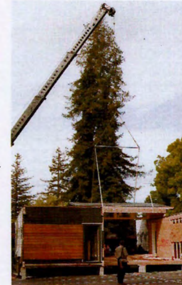
ΕΙΚ.184_ Τα πανέλα τοποθετούνται στην κατοικία, (πηγή:βιβλίο Prefab Green, Σελ.20)
