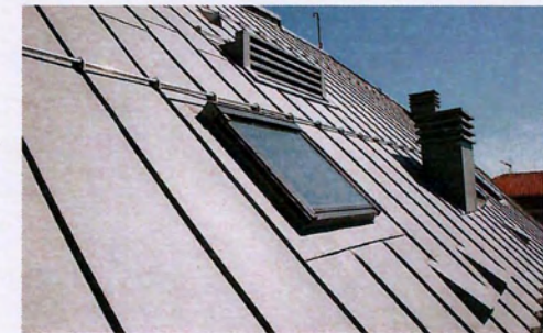
ΕΙΚ.148_ Επικάλυψη στέγης με αλουμίνιο, (πηγή: http://www.archiexpo.com/prod/mazzo-netto/standing-seam-aluminium-roof-panels-60371-158976.html )
