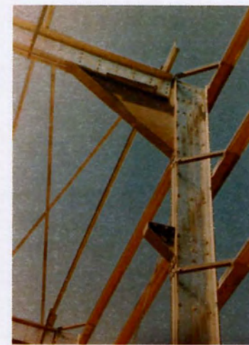
ΕΙΚ.293 Εφαρμογή Συνδεσμολογία διατομής "ΚΒ", (πηγή: Κατάλογος προϊόντων της KONTI Steel Hellas)
