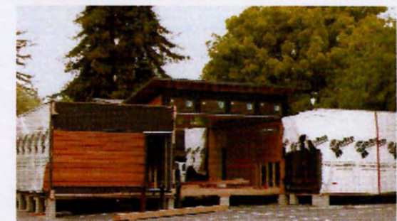
ΕΙΚ.185(πάνω)_Γερανός τοποθετεί τα κομμάτια στον τόπο εγκατ., ΕΙΚ.186 (κάτω)_Στον τόπο εγκατάστασης βιδώνεται και συναρμολογείται, (πηγή: βιβλίο Prefab Green, των Michelle Kaufmann/ Catherine Remick,Σελ.69)
