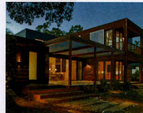
ΕΙΚ.6 Κατοικία με προκατασκευασμένα στοιχεία, (πηγή: βιβλίο Prefab Green, των Michelle Kaufmann/ Catherine Remick, Σελ. 2)
