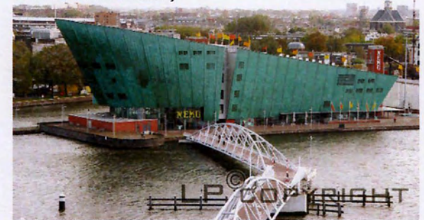
ΕΙΚ.149_ Επικάλυψη όψης με χαλκό στο κτίριο "Nemo" στο Άμστερνταμ, (πηγή: προσωπικό αρχείο συντακτριας 6-10-11)
