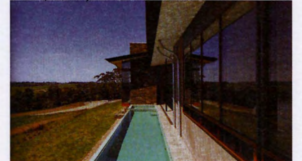
ΕΙΚ.338_ Οικία "Balhannah", μειωμένης κατανάλωσης ενέργειας, με Φ/Β πλαίσια που μετατρέπουν το φως ηλίου σε ηλ.ρεύμα και με υπόγεια δεξαμενή συλλογής νερού από τη στέγη, (πηγή:βιβλίο "150 ιδέες για υπέροχα οικολ. σπίτια", σελ.395)
