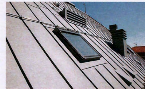
ΕΙΚ.148_ Επικάλυψη στέγης με αλουμίνιο, (πηγή: http://www.archiexpo.com/prod/mazzo-netto/standing-seam-aluminium-roof-panels-60371-158976.html )
