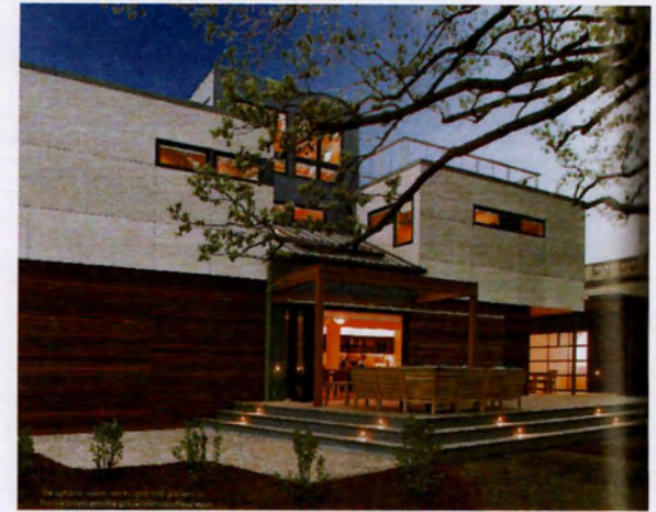
εικ.274_Οι εξωτερικοί χώροι, τα "decks", και οι κήποι οροφής της κατοικίας "MkSolaire" προσφέρουν χώρο και άνοιχτο προς το περιβάλλον , (πηγή: βιβλίο Prefab Green, των Michelle Kaufmann/ Catherine Remick, Σελ. 122)
