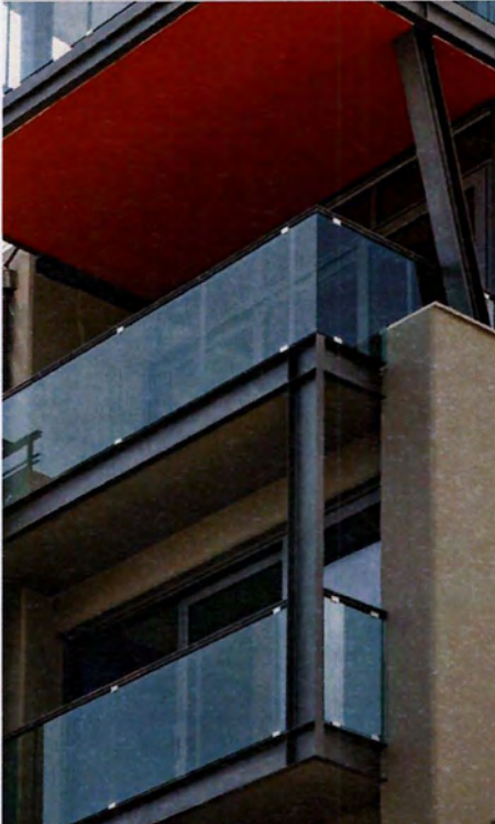
ΕΙΚ.125 Στοιχεία σημειακής στήριξης υαλοπινάκων κτιρίου Φροντηστηρίου "Λάνη" στον Βόλο (πηγή: προσωπικό αρχείο Κ.Αδαμάκη)
