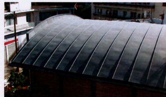
εικ.155_ Επικάλυψη στέγης κατοικίας (οδού Αμπελακίων στο Βόλο) με φύλλα ψευδάργυρου, (πηγή:προσωπικό αρχείο Κ.Αδαμάκη 2007)
