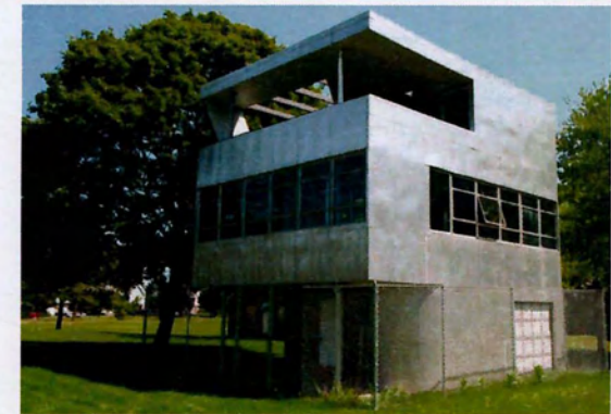
ΕΙΚ.147_ Επικάλυψη κτιρίου με αλουμίνιο, (πηγή: http://2ndterm2007.blogspot.com/ )
