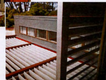
ΕΙΚ.273_Οι περισίδες λειτουργούν σαν σκηνή, επιτρέποντας τον αερισμό μέσα στα υπνοδωμάτια, εν.ω τα θωρακίζουν από την έντονη ακτινοβολία ,(πηγή: βιβλίο Prefab Green, των Michelle Kaufmann/ Catherine Remick, Σελ. 113)
