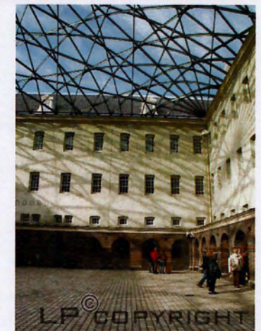
εικ.108, 109, 110_ Μεταλλική στέγη Ναυτικού Μουσείου στο Άμστερνταμ, με μεταλλικά "T" και κόμβους, (πηγή:προσωπικό αρχείο συντακτριας 6-10-11)
