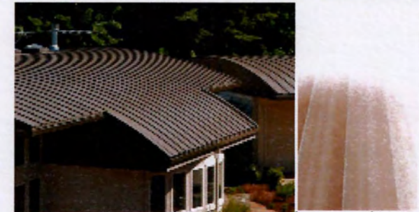
εικ.136 _ Μεταλλική στέγη με οριζόντια πανέλα, (πηγή: http://www.metalroofing.com/v2/content/p-hotogallery/ )
