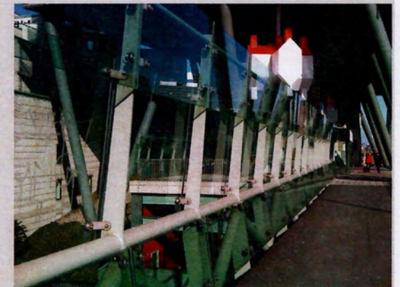
ΕΙΚ.130- 133 σημειακή στήριξη υαλοπινάκων με βραχίονες (πηγή: προσωπικό αρχείο συντάκτριας, Χάγη 25-2-12)
