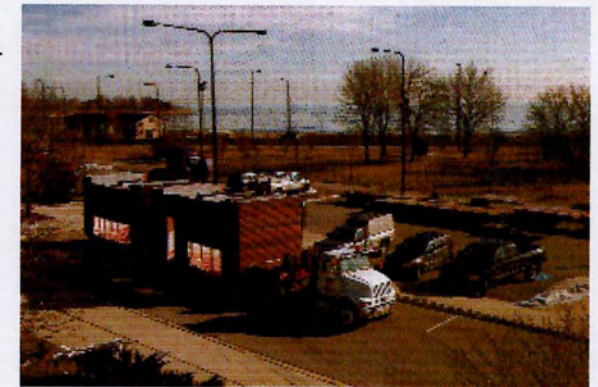
ΕΙΚ.189_ Προκατ.κατοικία φτάνει στον χώρο της εγκατάστασης, (πηγή:βιβλίο "Prefab Green", των Michelle Kaufmann/ Catherine Remick, Σελ.65)
