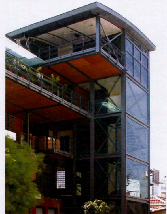
εικ.239 _ όψη από την οδό Ι.Καρτάλη Μεταλλικού κτιρίου της εταιρίας "Planning" στον Βόλο, (2011), (πηγή: προσωπικό αρχείο Κ.Αδαμάκη)
