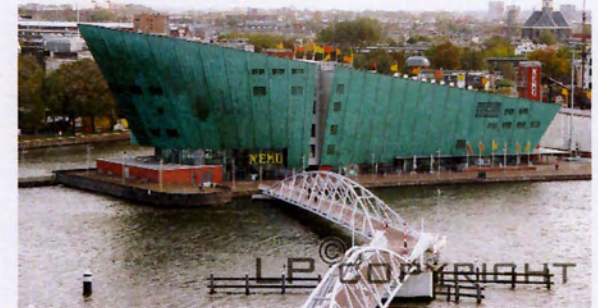
ΕΙΚ.149_ Επικάλυψη όψης με χαλκό στο κτίριο "Nemo" στο Άμστερνταμ, (πηγή: προσωπικό αρχείο συντακτριας 6-10-11)
