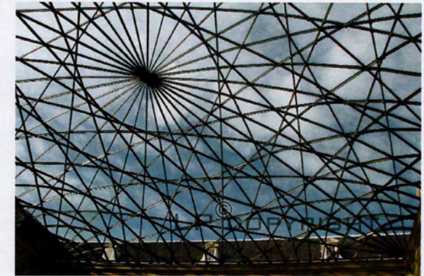
εικ.108, 109, 110_ Μεταλλική στέγη Ναυτικού Μουσείου στο Άμστερνταμ, με μεταλλικά "Τ" και κόμβους, (πηγή:προσωπικό αρχείο συντακτριας 6-10-11)
