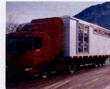
εικ.234_Μεταφορά κατοικίας "Su-Si" με φορτηγό (πηγή: βιβλίο XS:Big Ideas-Small Buildings, Σελ.169)
