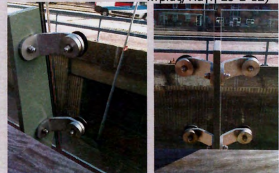
ΕΙΚ.130- 133 σημειακή στήριξη υαλοπινάκων με βραχίονες (πηγή: προσωπικό αρχείο συντάκτριας, Χάγη 25-2-12)
