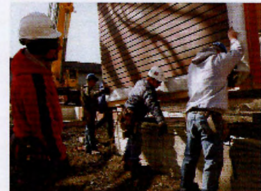
εικ.207-9_ Προετοιμασία του τόπου εγκατ., μετακίνηση με γερανό και μοντάρισμα κατοικίας (πηγή: βιβλίο "Prefab Green", των Michelle Kaufmann/ Catherine Remick, Σελ.67)
