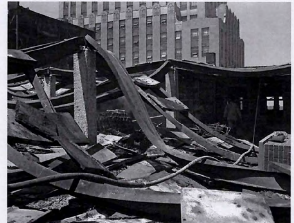
εικ.158_ Δοκοί χάλυβα μετά από πυρκαγιά, (πηγή: http://blogs.sj-r.com/behindthecurtain/index.php/2009/05/03/to-wering-inferno/ )
