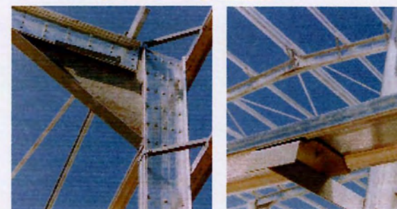
εικ.284,285_Λεπτομέρειες συνδεσμολογίαςστοιχείων διατομής C, (πηγή: Κατάλογος προϊόντων της KONTI Steel Hellas)
