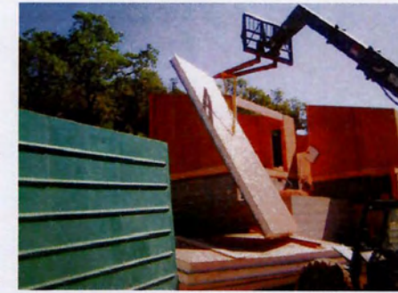
ΕΙΚ.184_ Τα πανέλα τοποθετούνται στην κατοικία, (πηγή:βιβλίο Prefab Green, Σελ.20)
