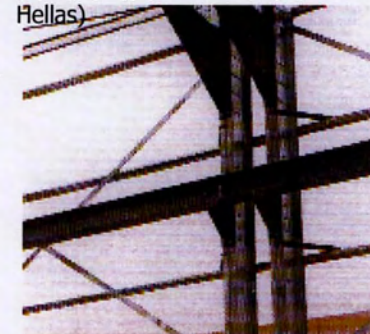
ΕΙΚ.288_ Λεπτομέρειες συνδεσμολογίας κολώνας-υποστηλώματος διατομής C, (πηγή: Κατάλογος προϊόντων της KONTI Steel Hellas)
