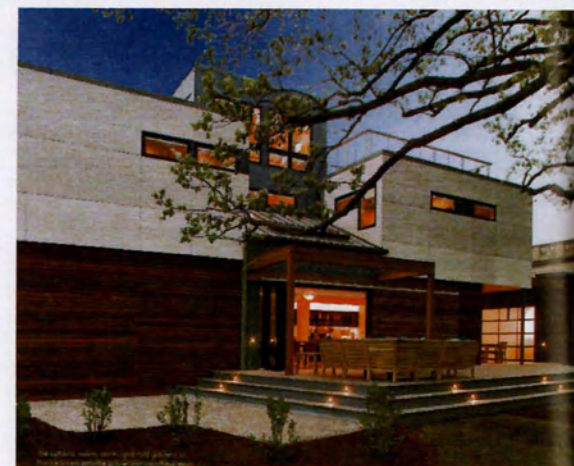
εικ.274_Οι εξωτερικοί χώροι, τα "decks", και οι κήποι οροφής της κατοικίας "MkSolaire" προσφέρουν χώρο και άνοιχτο προς το περιβάλλον (πηγή: βιβλίο Prefab Green, των Michelle Kaufmann/ Catherine Remick, Σελ. 122)
