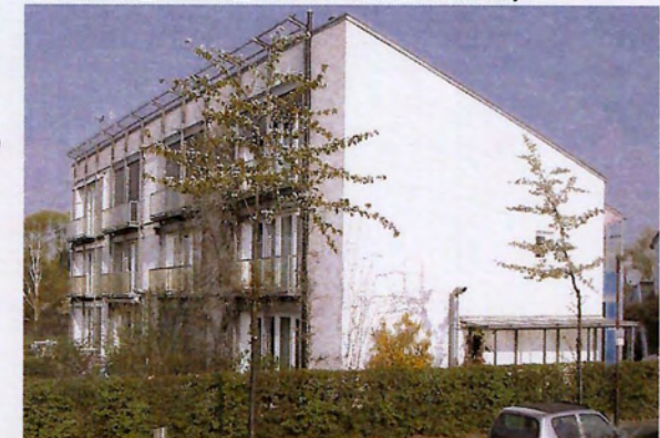
ΕΙΚ.62 Στην ανατολική πλευρά διακρίνεται το στόμιο εξαερισμού της κατοικίας ακόμη και αν τα παράθυρα μένουν κλειστά για αρκετές μέρες, και ΕΙΚ. (κάτω) "Παθητική κατοικία" στο Darmstadt Kranichstein
