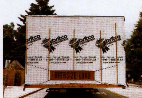
ΕΙΚ.183_τα μέρη της κατοικίας μεταφέρονται με φορτηγό στο τόπο εγκατάστασης, (πηγή: βιβλίο Prefab Green, των Michelle Kaufmann/ Catherine Remick, Σελ.68)
