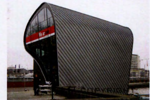
εικ.151-152_Επικάλυψη όψης με "AluPlusZinc" (μείγμα αλουμινίου με ψευδάργυρο), στο κτίριο "The Architectural Chamber of Amsterdam (ARCAM)" στο Άμστερνταμ, (πηγή:προσωπικό αρχείο συντακτριας 6-10-11 και 21-12-2006)
