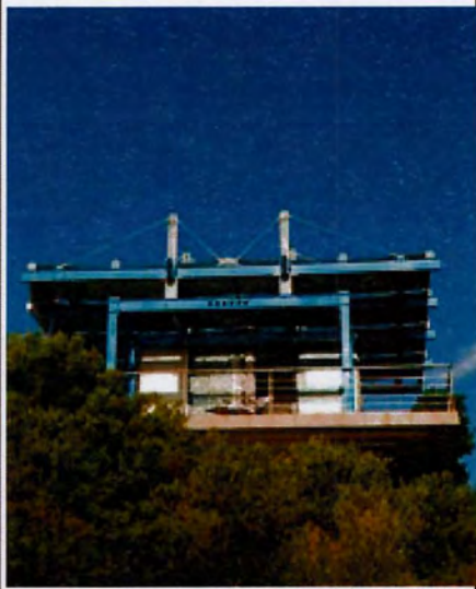
εικ.238_ Γενική άποψη μεταλλικής κατοικίας σε πλαγιά στην Αλόνησο. (πηγή: http://www.gapinteriors.com/imagedetails.asp?im-ageno=56416 )
