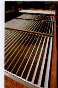
ΕΙΚ.5 Ρυθμιζόμενα ηλιοπροστατευτικά στην κατοικία "Breezehouse" εμποδίζουν την ηλιακή θερμότητα, (πηγή: βιβλίο Prefab Green, των Michelle Kaufmann/ Catherine Remick, Σελ. 50)
