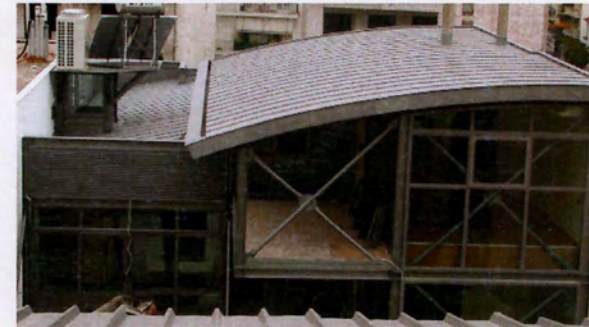
εικ.240 _ στέγη τιτανιούχου ψευδάργυρου μεταλλικού κτιρίου της εταιρίας "Planning" στον Βόλο, (2011), (πηγή: προσωπικό αρχείο Κ.Αδαμάκη)
