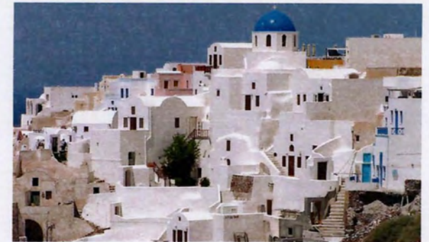
ΕΙΚ.351 _πυκνή δόμηση, στενοί δρόμοι, εσωτερικές αυλές, σκίασμός χαρακτηρίζουν την πολεοδομική διάταξη της Σαντορίνης (περιοχή με θερμό, ξηρό κλίμα, (πηγή: http://www.24h.gr/section/periballon/sto-mikroskopio-i-domisi-tis-santorinis )
