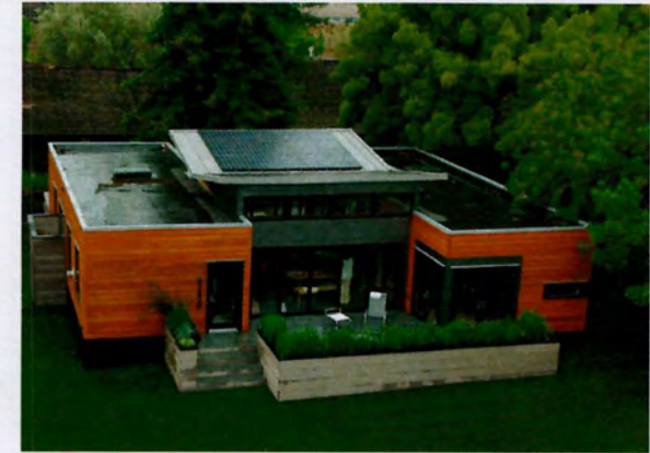
ΕΙΚ.7_ Προκατασκευασμένο πράσινο κτίριο με ενσωματωμένα ηλιακά πάνελ, σχεδιασμένο από τον Michael kaufmann (πηγή: http://news.cnet.com/8301-11128_3-10250334-54.html )
