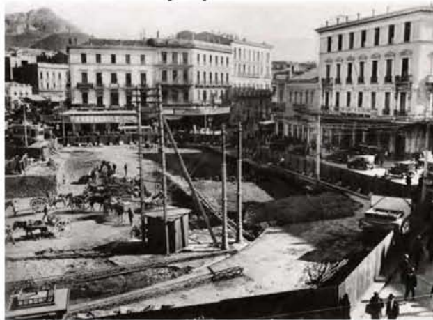
Εικόνα 6.4: Κατασκευή του σταθμού του ηλεκτρικού σιδηρόδρομου στην Ομόνοια-1920
