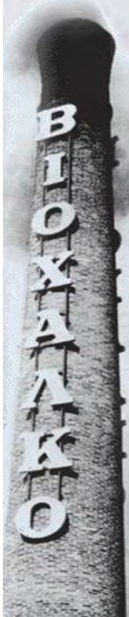
Εικόνα 13: Η καμινάδα του εργοστασίου ΒΙΟΧΑΛΚΟ
