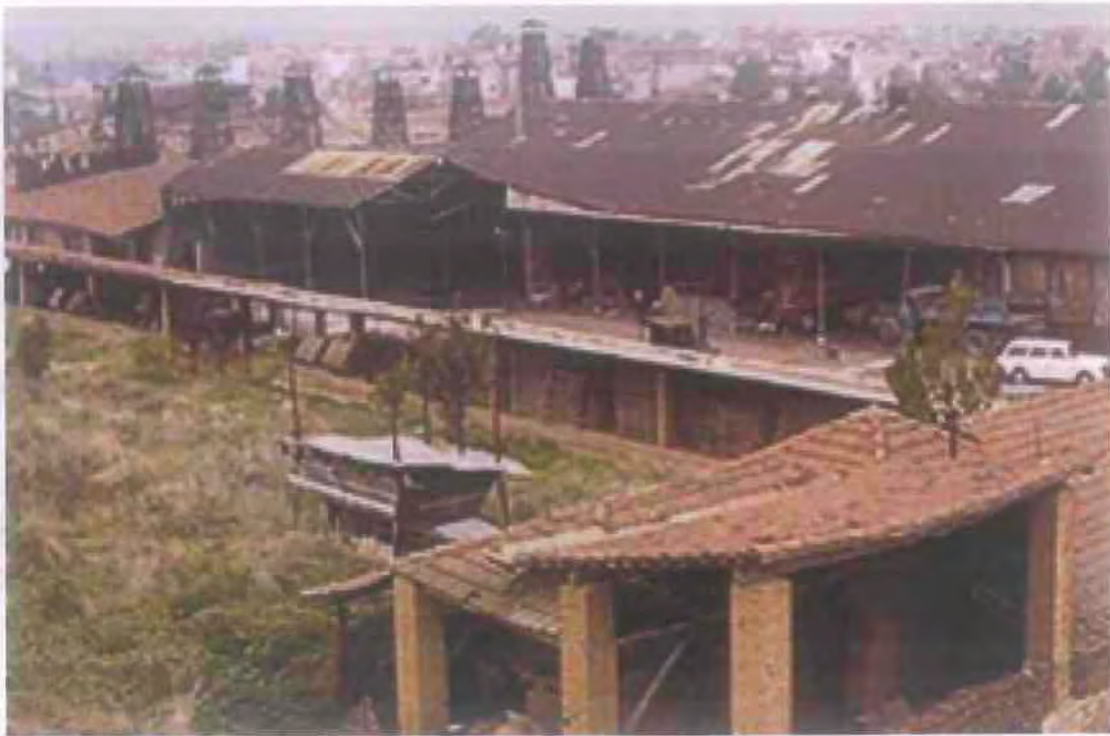
5. Κτίριο Τσαλαπάτα πριν την παρέμβαση
