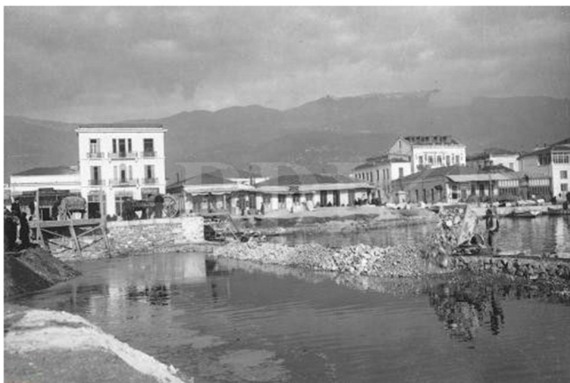
Εργασίες αποκατάστασης του βομβαρδισμένου λιμανιού. Πηγή ΔΗΚΙ
