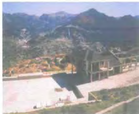
Φωτ. 31 : Παγοδρόμιο (υπό κατασκευή)
