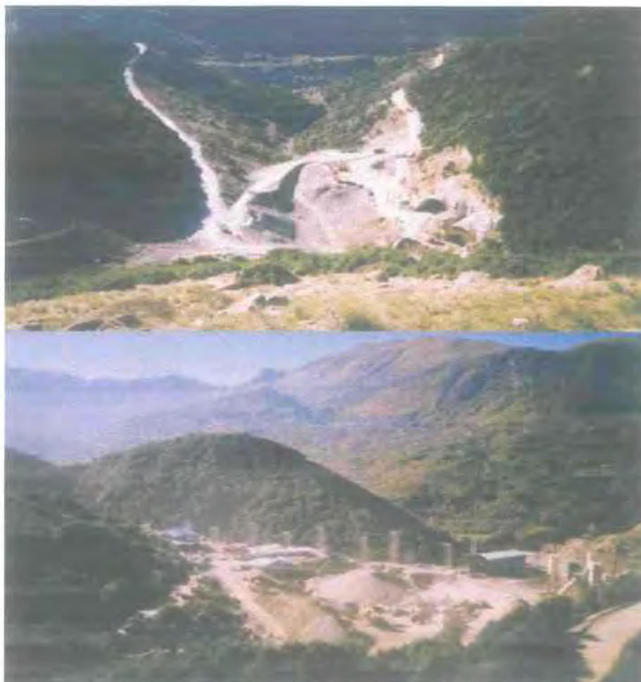
Φωτ. 32 & 33 : Κατασκευαστικά έργα (τούνελ και γέφυρα) Εγνατίας Οδού
