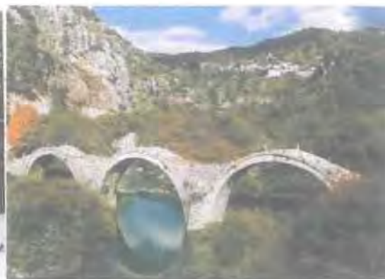
Φωτ. 15 : Το γεφύρι Πλακίδα
