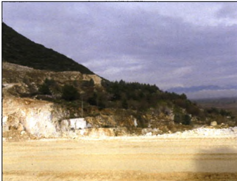
Εικόνα 28: Κοντινή άποψη αποκατάστασης αναβαθμίδων με στείρα και φυτεύσεις σε τμήμα του λατομείου.
