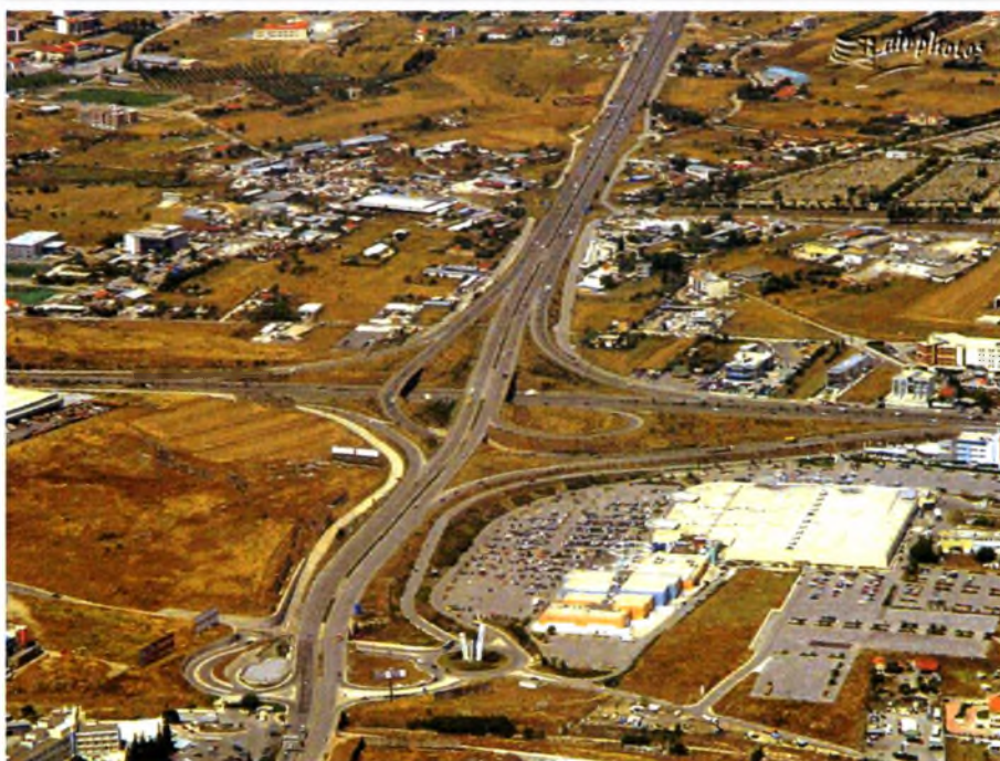
Φωτ 2: Περιοχή περιφερειακής στο ύψος του Carrefour (ανατολικά)
