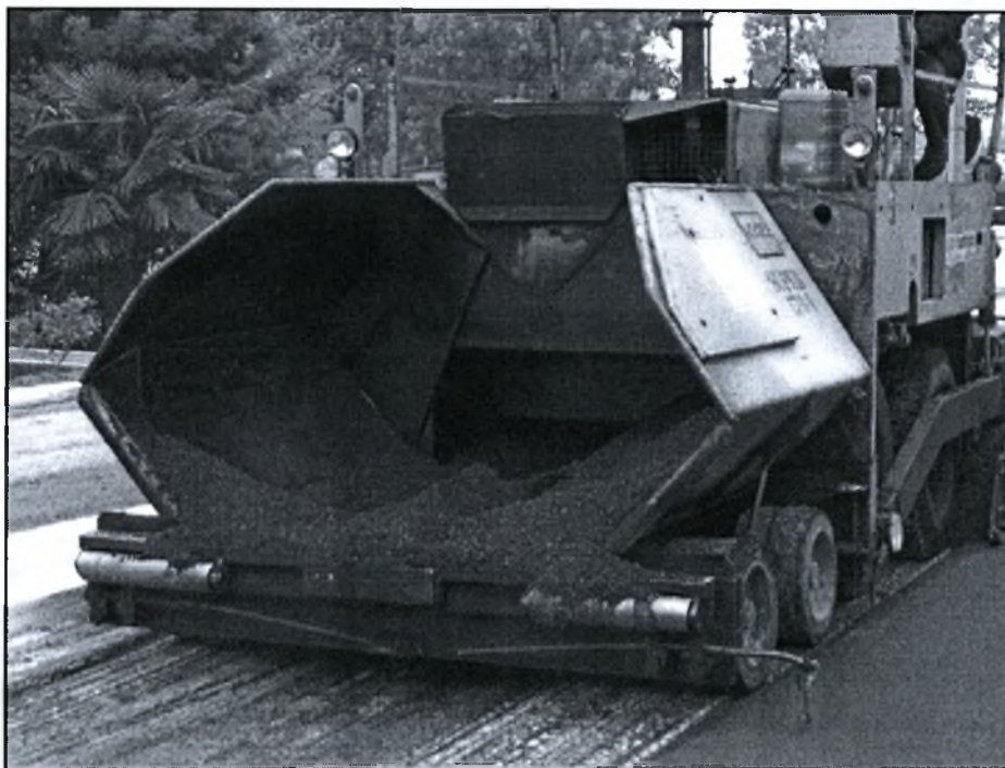
Εικόνα 16. Στιγμιότυπο εργασίας διάστρωσης ασφαλτοσκυροδέματος με ειδικό μηχάνημα (finisher) (Πηγή: προσωπικό αρχείο Δημήτρη Τσιώτα).
